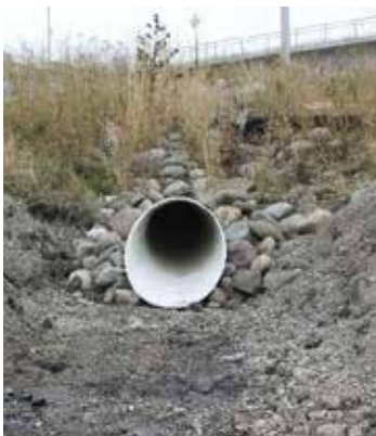
A-side invert (before)
